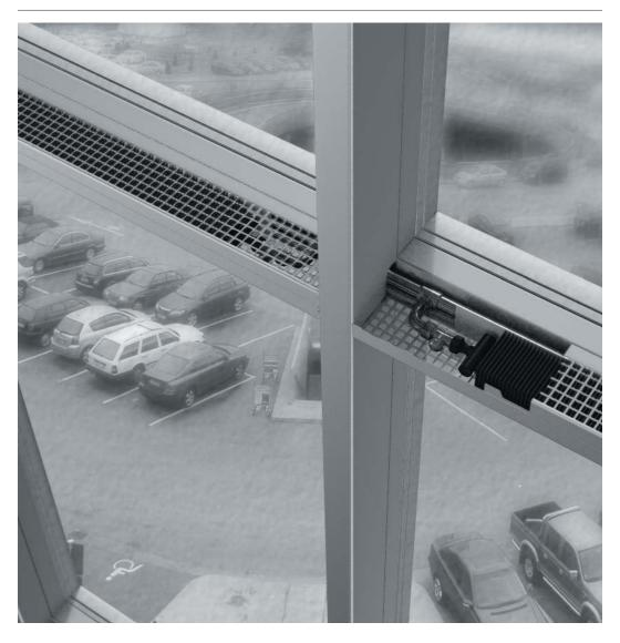
Система фасадного обогрева FassadenKlima — современный экономичный отопительный прибор, работающий по принципу естественной конвекции и предназначенный для эксплуатации в однотрубных и двухтрубных системах водяного отопления с принудительной циркуляцией теплоносителя в любых типах зданий со стеклянными фасадами большой площади и высоты.
